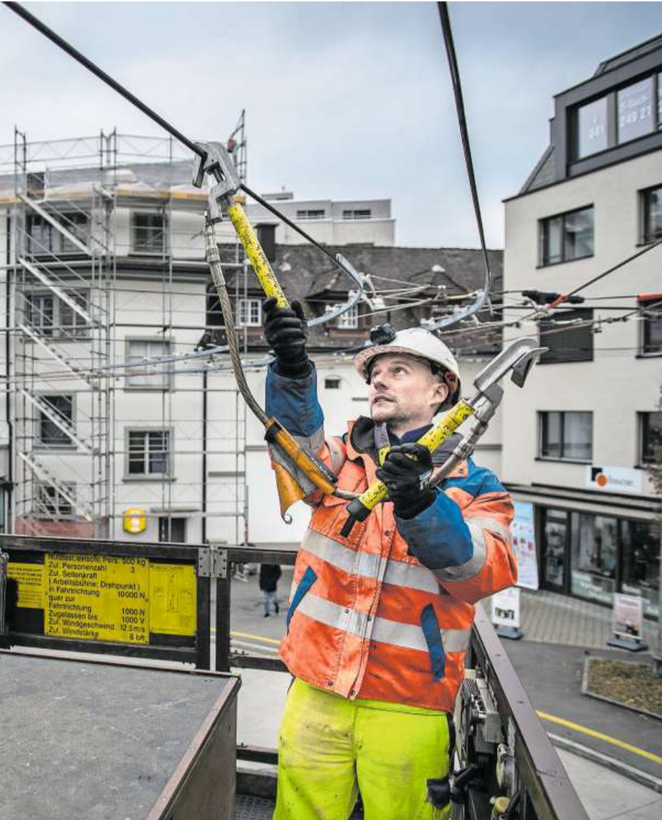
Montage der neuen Fahrleitungen der Linie 5. Bild: Boris Bürgisser (Kriens, 29. November 2016)
